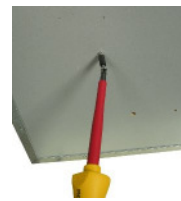
4. Befestigungen einschrauben
